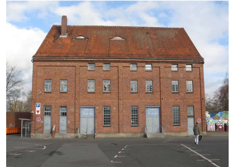
Abriss Schornstein Ergänzung 3. Fledermausdachgaube
